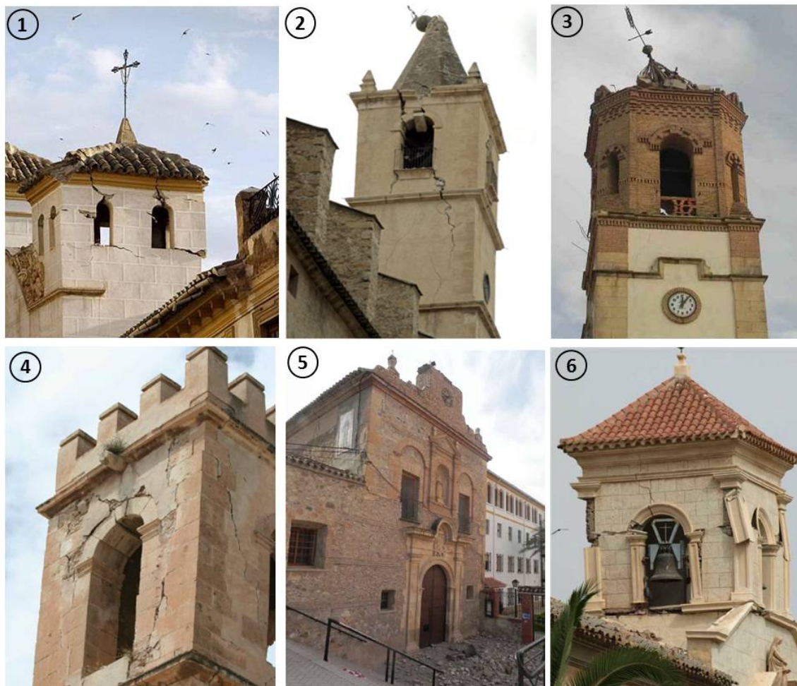
Figure 5: Damages to the towers of, 1) Chapel of Rosario; 2) San Francisco; 3) Virgen de las Huertas; 4) San Pedro; 5) San Diego (belfry fall); 6) Convent of Clarisas.
