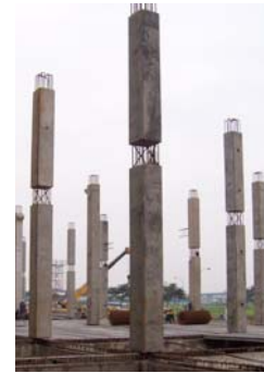
b. Precast columns
