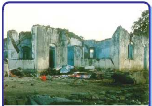
ਓ) ਬਗੈਰ ਹੋਰੀਜੈਂਟਲ ਲਿੰਟਲ ਬੈਂਡ ਦੀ ਇਮਾਰਤ: ਛੱਤ ਅਤੇ ਦੀਵਾਰਾਂ ਦਾ ਢਹਿ ਜਾਣਾ
