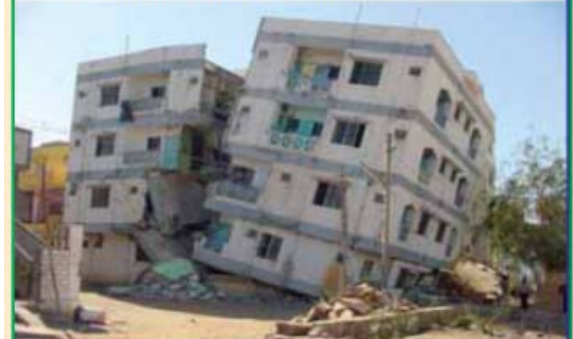
(ਖ) ਭੁਜ (ਭਾਰਤ) ਵਿਖੇ 2001 ਦੇ ਭੂਚਾਲ ਦੌਰਾਨ ਢੰਠੇ ਹੋਏ ਰਿਇਨਫੋਰਸਡ ਕੰਕ੍ਰੀਟ ਥੰਮ੍ਹ ਅਤੇ ਇਮਾਰਤਾਂ ਚਿੱਤਰ 5 - ਭੂਚਾਲ ਦੌਰਾਨ ਹੌਰੀਜ਼ੈਂਟਲ ਬਲਾਂ ਨੂੰ ਸਹਿਣ ਵਾਲੇ ਥੰਮ੍ਹਾਂ/ਕੰਧਾਂ ਦੇ ਡਿਜ਼ਾਇਨ ਦਾ ਮਹੱਤਵ
